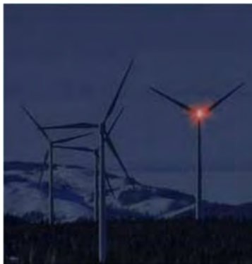
Lampe à éclats sur une éolienne
